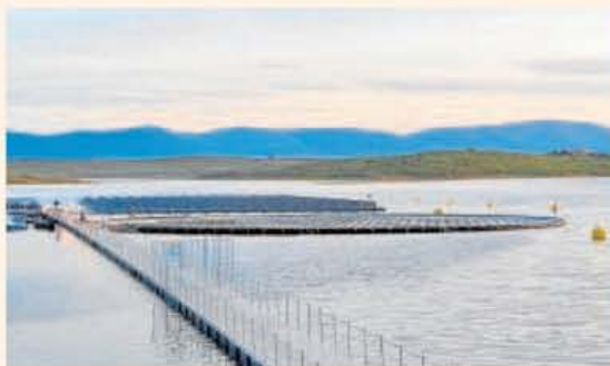
La primera de las Islas Baleares Balsa de riego de Consell (Mallorca), la primera de las Islas Baleares, ocupa 275 m² sobre los 11.000 m² de la lámina de agua de la balsa y cuenta con 72 placas solares que producirán 30 kW de potencia para autoconsumo del sistema de regadío
