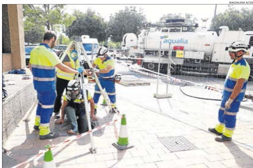
Un técnico revisó ayer la zona accediendo al subsuelo a través de una boca de alcantarilla.
