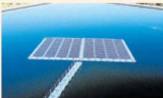
La primera de las Islas Baleares Balsa de riego de Consell (Mallorca), la primera de las Islas Baleares, ocupa 275 m² sobre los 11.000 m² de la lámina de agua de la balsa y cuenta con 72 placas solares que producirán 30 kW de potencia para autoconsumo del sistema de regadío
