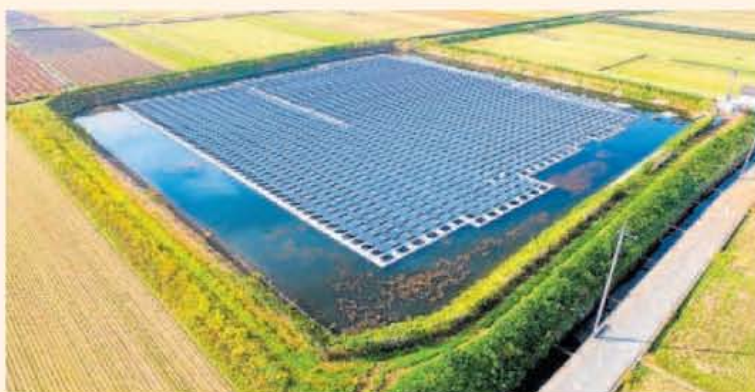
Veteranos en balsas de riego La empresa Sivortex lleva más de una década diseñando sistemas fotovoltaicos flotantes para balsas de riego de comunidades de regantes. Imagen superior e izquierda, una de esas instalaciones
