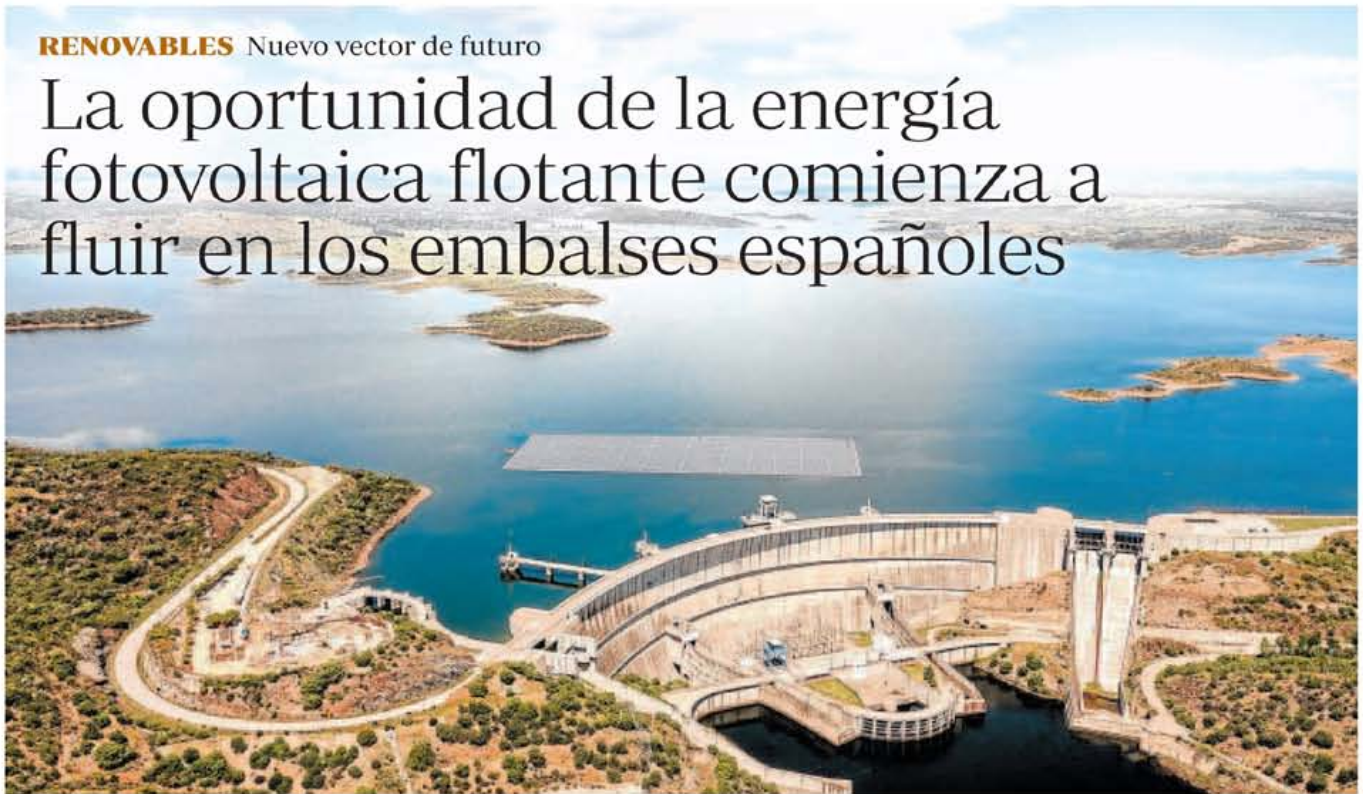
Planta fotovoltaica flotante de EDP en el embalse de Alqueva (Portugal)
