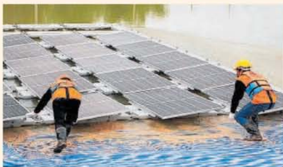
Veteranos en balsas de riego La empresa Sivortex lleva más de una década diseñando sistemas fotovoltaicos flotantes para balsas de riego de comunidades de regantes. Imagen superior e izquierda, una de esas instalaciones
